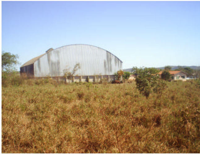
Figura 35. Armazém da Cooperativa Coqueiral/Quebó em Roda d'Água (Coordenadas 610695 / 8391234) (Foto: Carla Moraes).
