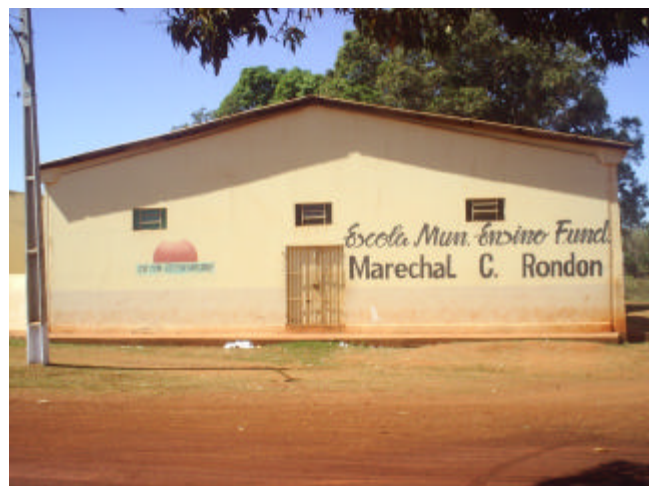
Figura 38. Escola em Roda d'Água (coordenadas: 610332/8392032) (Foto: Carla Moraes).
